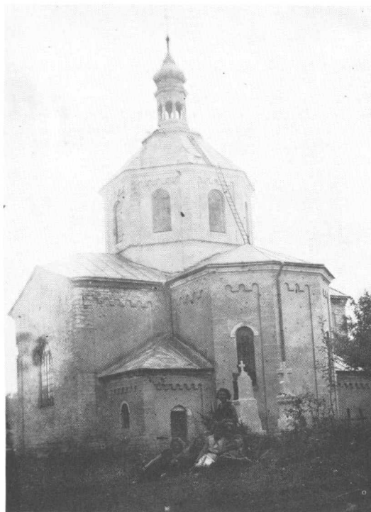
Церква в селі Шибалині після відбудови в 1927 р.
