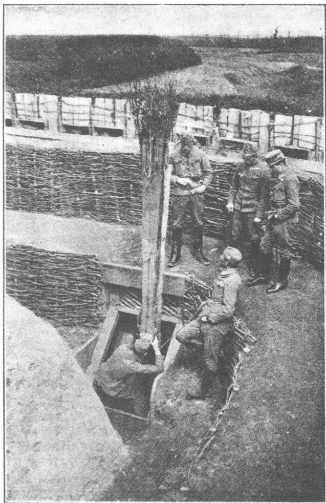
Періскоп, прилад до обсервації передпілля зі землянок.
